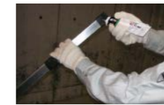
下地側は穴を通してスチール部ごとコンパネビス止め
